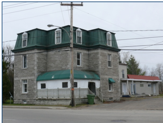
L'hôtel Perreault Crédit photo : Patri-Arch
