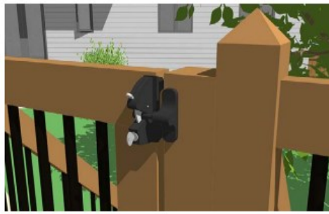
Exemple de loquet permettant à la porte de se verrouiller automatiquement. La porte devrait aussi être munie de pentures à ressort afin de se refermer automatiquement.
